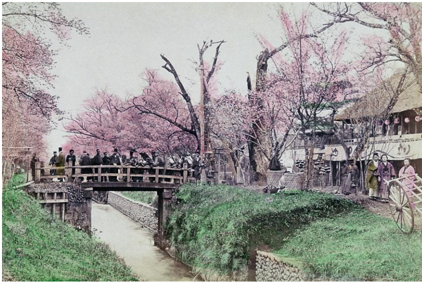
①明治時代の小金井橋（石橋）
