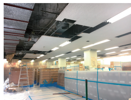
本館1階工事の様子
