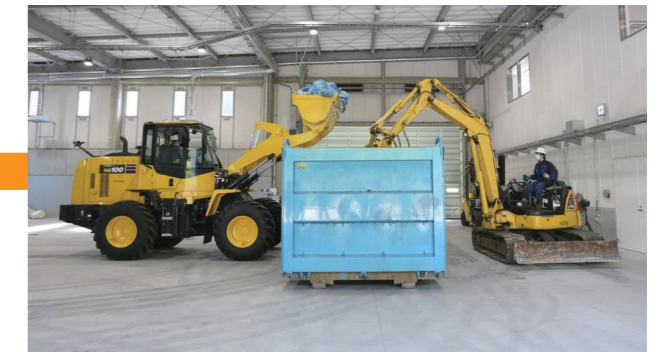
重機による積替え
