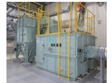
④ バグフィルタ(集じん装置)・脱臭装置
