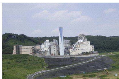
写真 東京たまエコセメント化施設
