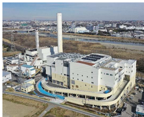
写真 新施設全景（令和2年2月）
