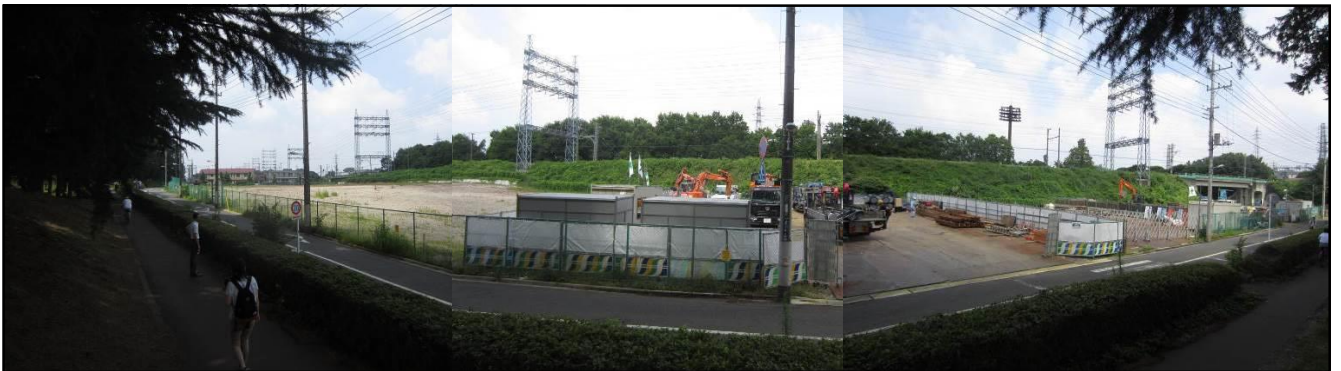
敷地を東から見る
