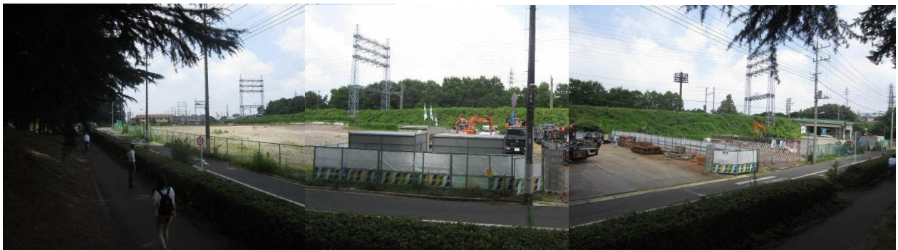
敷地を東から見る
