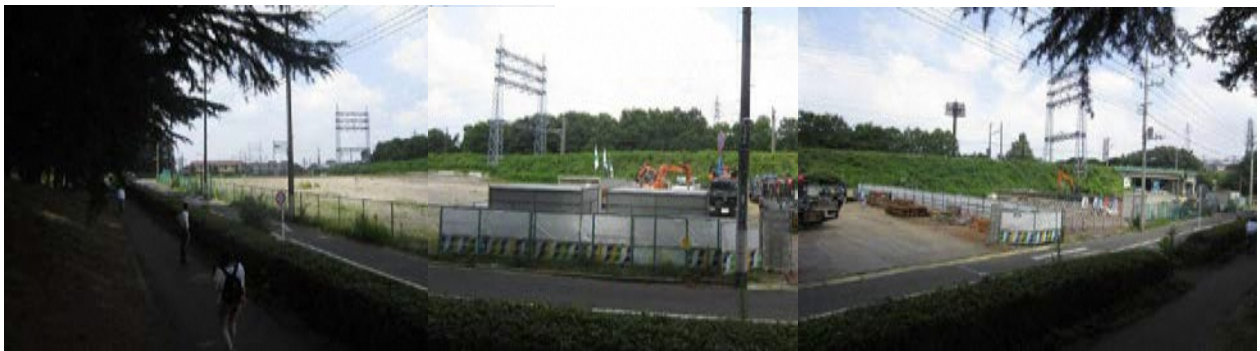
敷地を東から見る
