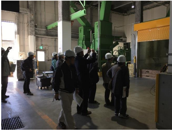
金属圧縮機・カレットストックヤード
