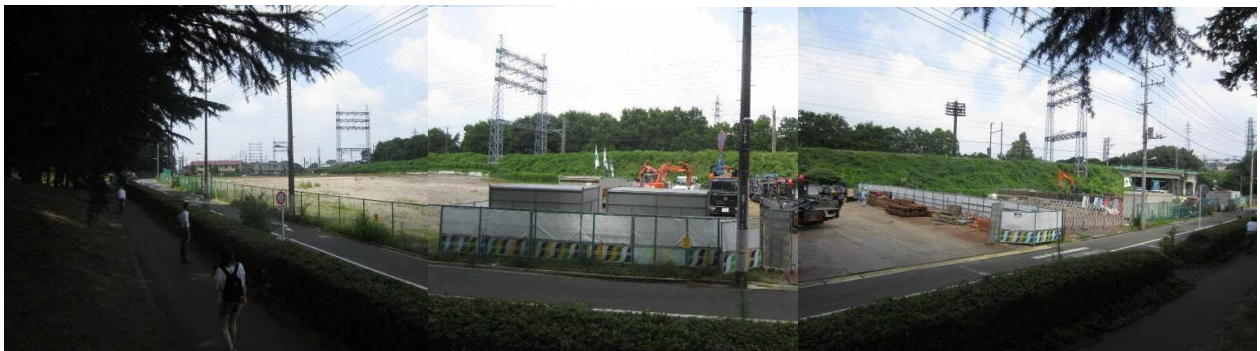
敷地を東から見る
