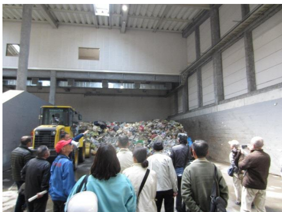
不燃ごみ受入ヤード
