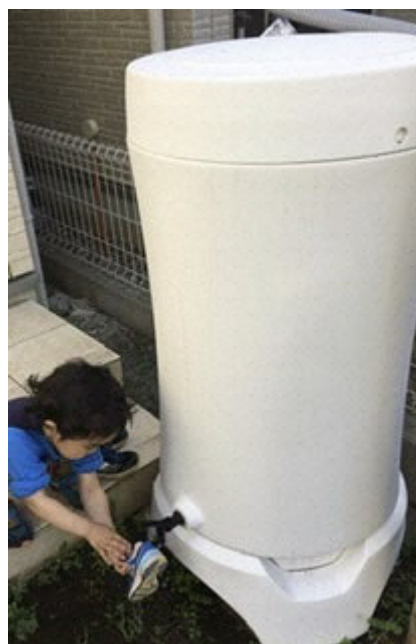
写真 2-3 雨水タンクの例
