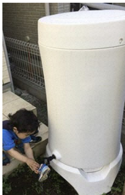
写真 3-6 雨水タンクの例
