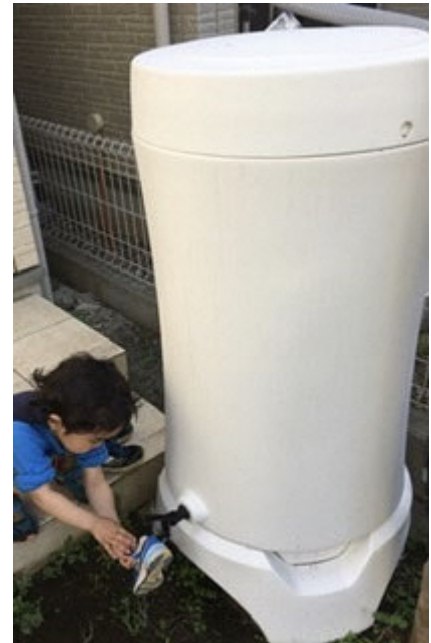
写真 2-2 雨水タンクの例
