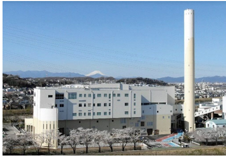
写真 3-4 可燃ごみ処理施設
