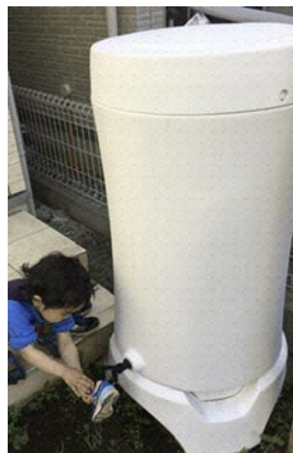
写真 3-14 雨水タンクの例
