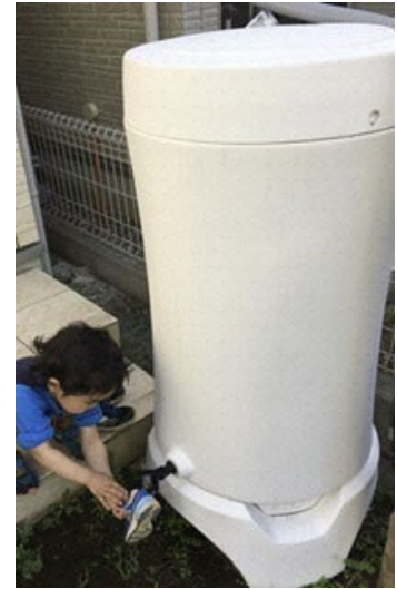
写真- 6 雨水タンクの例
