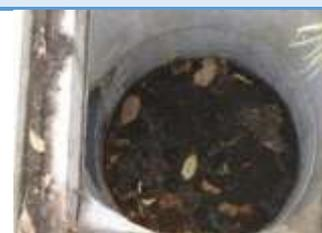
浸透ますの底部が土砂で覆われた状態<sup>※</sup>
