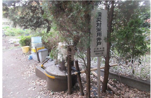
写真-7 震災対策用井戸の例
