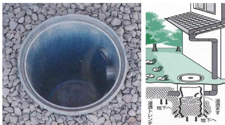
図-12 雨水浸透ますの設置例(左)と概念図(右)
