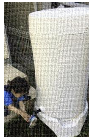
写真-6 雨水タンクの例
