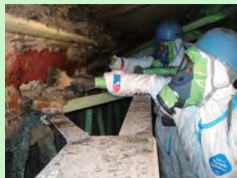
吹付け石綿の除去作業の様子
