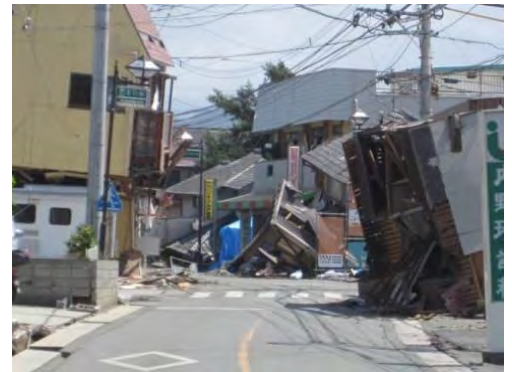
地震で損壊した建物
