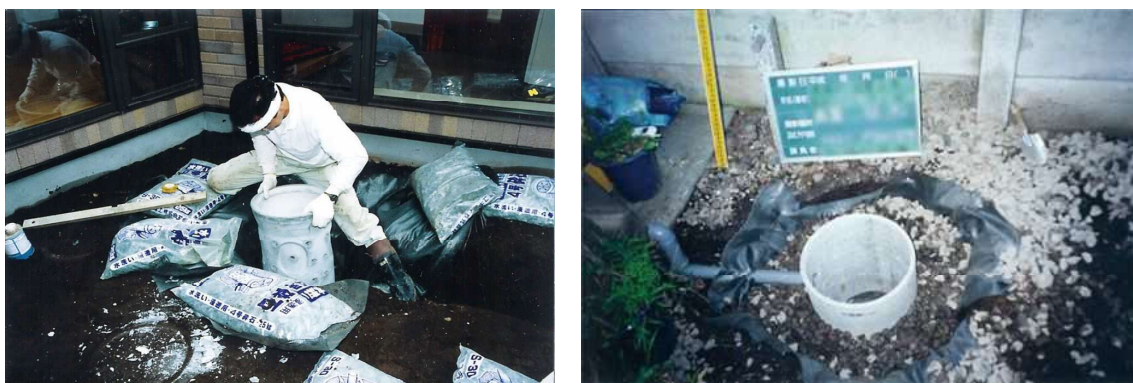
図 4-7 雨水浸透ます設置工事
