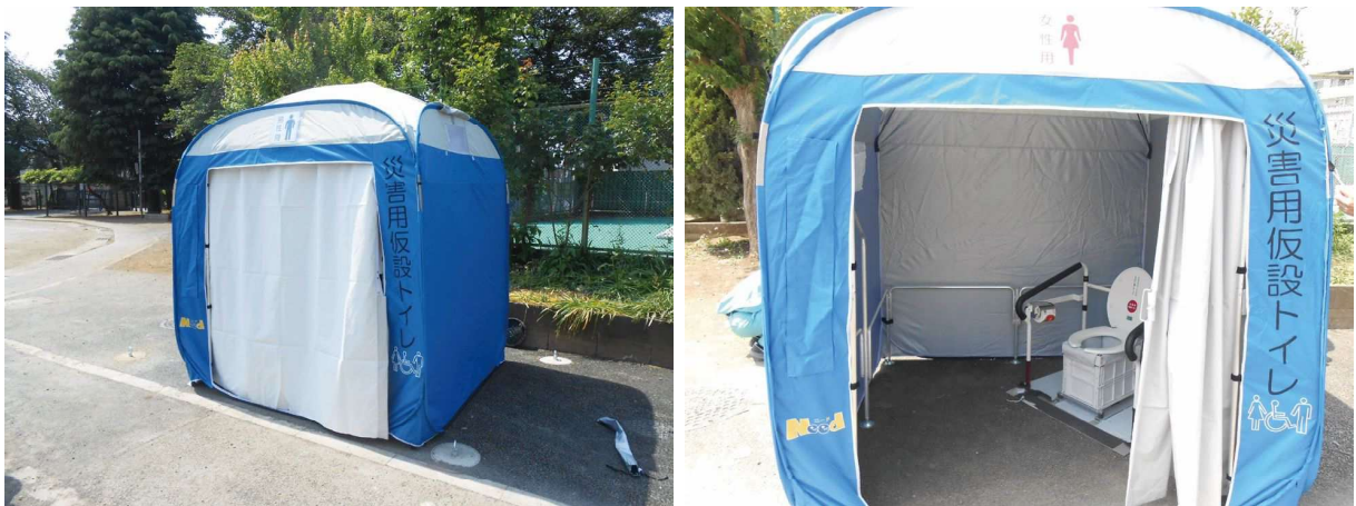
図3-8 マンホールトイレ写真
