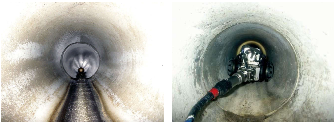
図 4-3 管路カメラ調査
