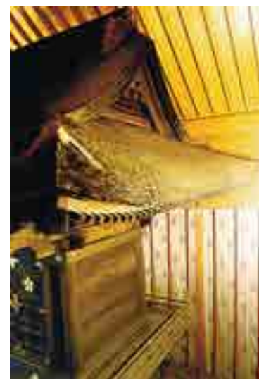
屋根 瓦ではなく柿葺きです。屋根の頂点には鬼板が乗ります。
