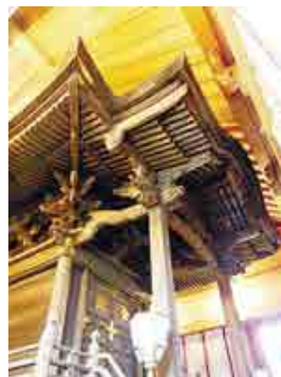
向拝 お社の前面に張り出している軒の部分で礼拝する場所です。
