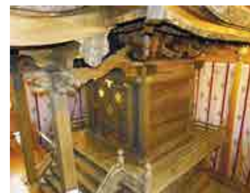
全景 18世紀中期の建築ですが、保存状態は良好です。金具類は戦時中に供出され、戦後に補修されています。
