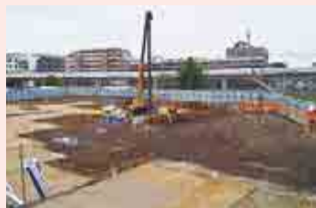
山留工事のようす
