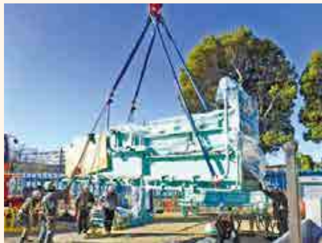
プラント機器搬入の様子
