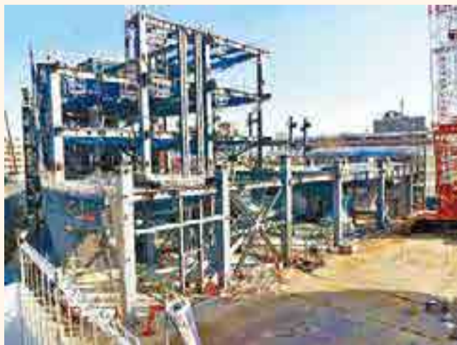
躯体工事の様子
