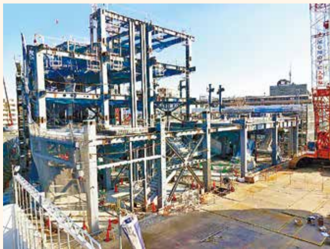
躯体工事のようす
