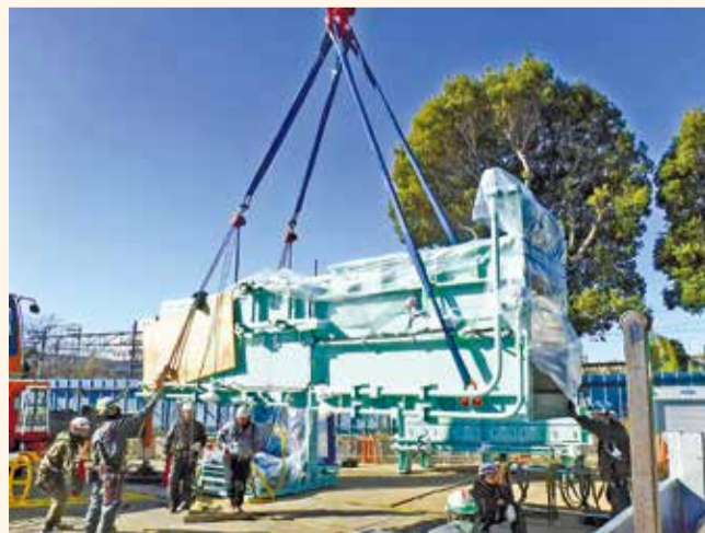
プラント機器搬入のようす
