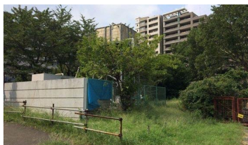
⑤非常災害用給水施設
