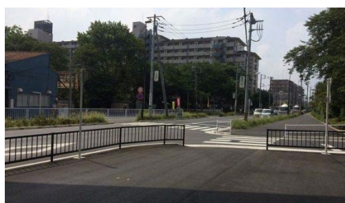
敷地北西側より（奥がトミンハイム）
