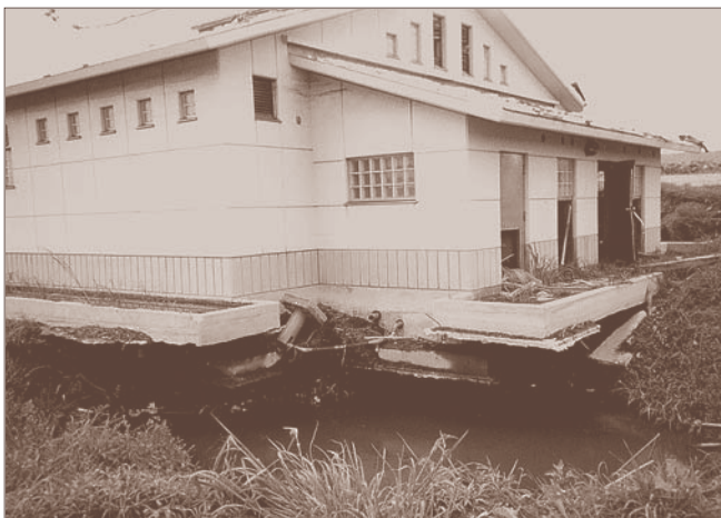
海水浴場シャワー棟
