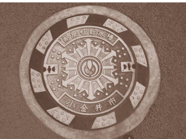
耐震性貯水槽(100t)のふた部分
