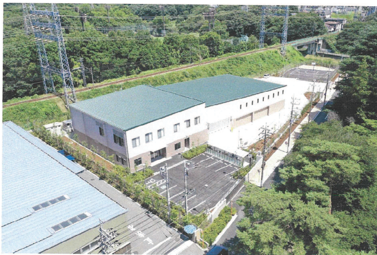
小金井市野川クリーンセンター（令和4年7月竣工）
