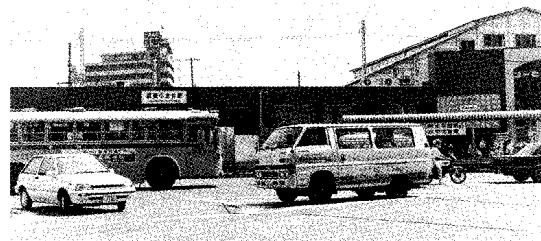
武蔵小金井駅北口広場の整備が求められている
