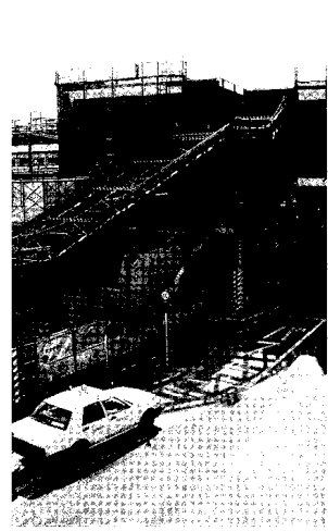
仮駅舎の建設も進む立体的交差化事業(武蔵小金井駅北口)
