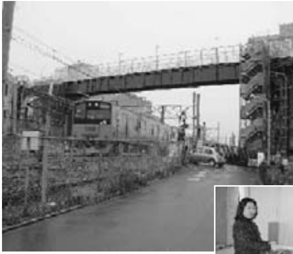
緑町踏切に仮設された歩道橋
