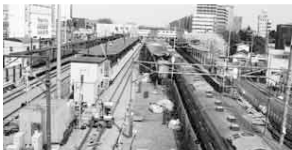
着々とすすむJR中央線高架化工事
