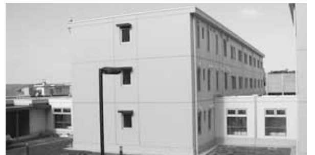
三宅村活動火山対策避難施設
