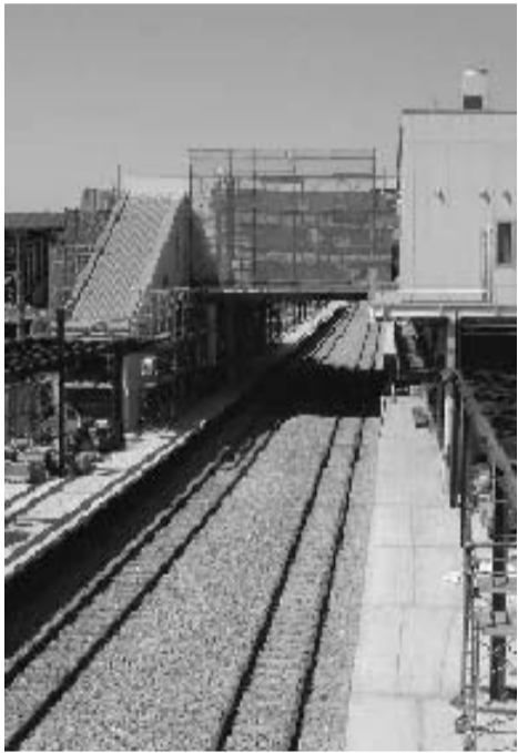
飯線工事で生まれ変わる武蔵小金井駅
