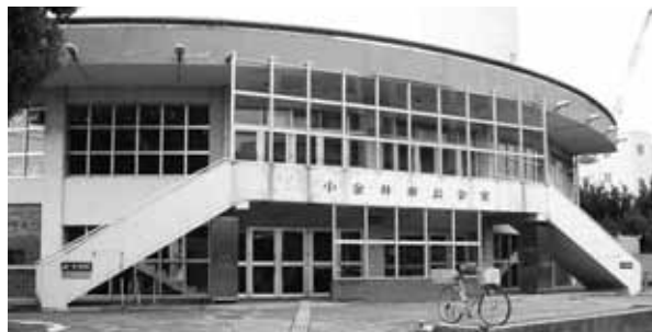
老朽化が進む公会堂
