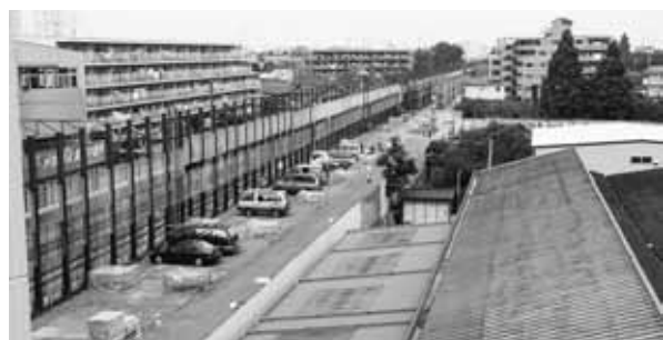
高架化が進む中央線とジャノメ跡地
