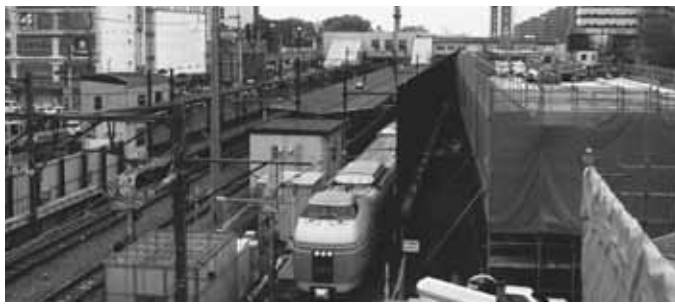
高架工事が進むJR中央本線
