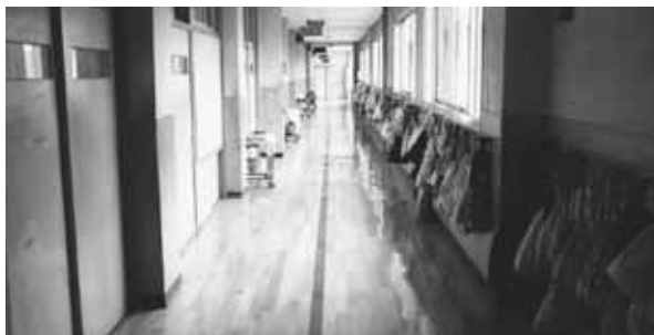
木質化された廊下
