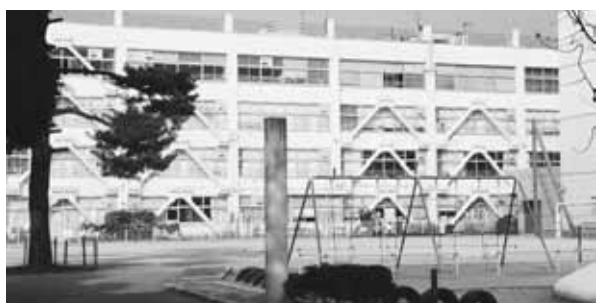
耐震化が進む小・中学校
