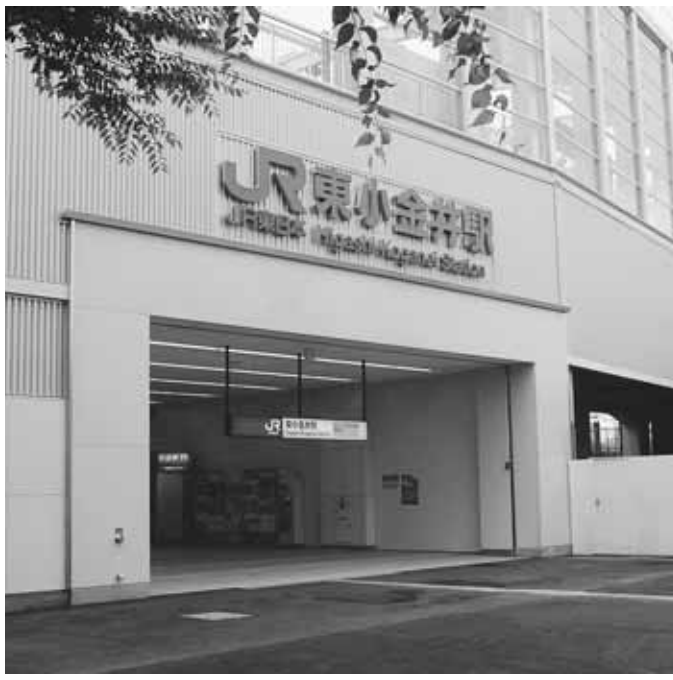
高架化によって新しくなった東小金井駅舎
