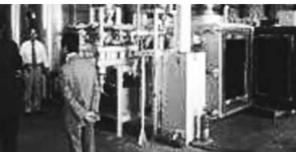
非焼却施設(炭素化)の実証施設
