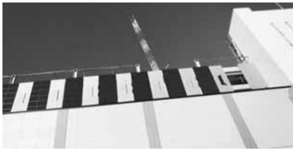
竣工した商業ビルの壁面太陽光パネル(再開発)
