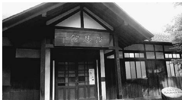
築80年以上の文化財センター (浴恩館)
