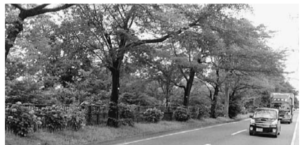
安全対策が切望される大木の繁茂で被圧され道路側に枝を伸ばす玉川上水の桜並木
