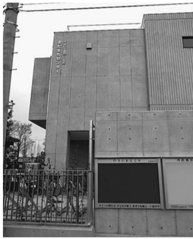
平成26年4月にオープンした貫井北センター
