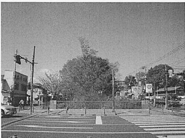
未整備区間の現況 小金井橋
