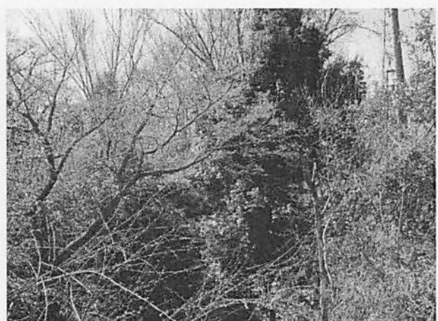
未整備区間の現況 貫井橋
