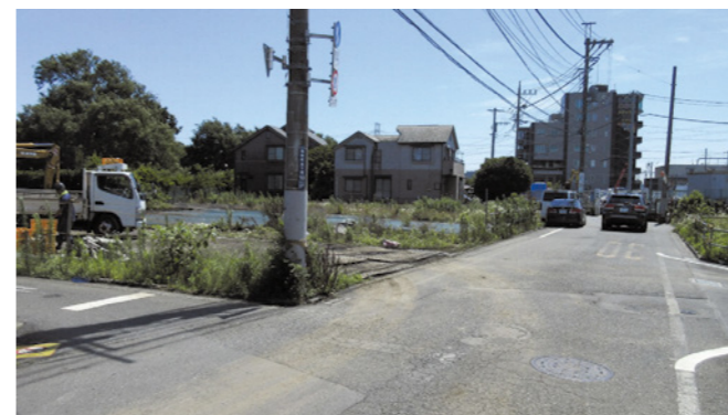
■小3・4・16東小金井駅北口東西線の工事着手前後 【着手前】令和2年7月
