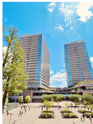
武蔵小金井駅南口地区
