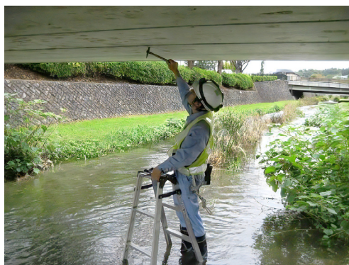
橋りょう点検
