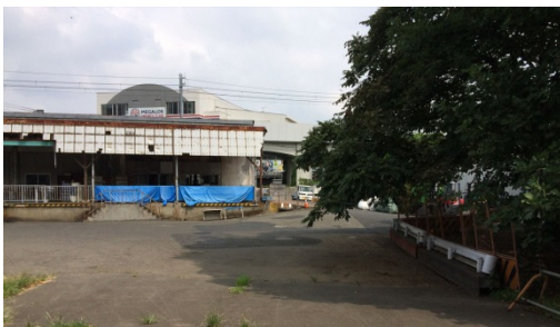
写真中央マンホール下に④防火水槽
