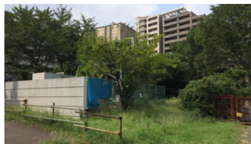
⑤非常災害用給水施設
