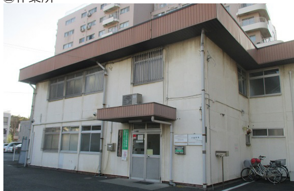
③多目的作業所(2階一部)
