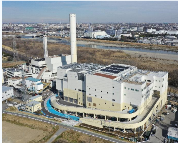
浅川清流環境組合 新可燃ごみ処理施設 設全景
