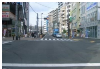
主要地方道15号線
