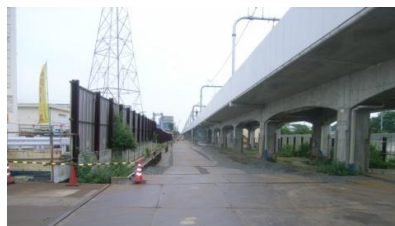
JRまちづくり側道(市道786号線)用地
